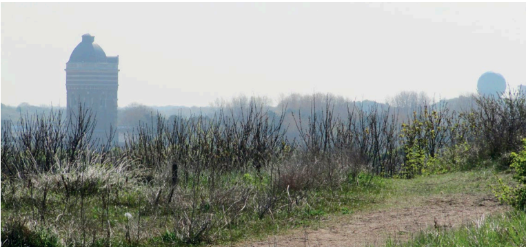
Dicht bij de tankmuur van Scheveningen lag een Duitse bunker met waarnemingspost. De waarnemingspost is gemeentelijk monument. Op de Duitse bunker staat nu radarapparatuur afgeschermd met bolvormig ruimtevakwerk. Samen met de watertoren bepaalt de grote radarbol de skyline van het duin ten noorden van Scheveningen en Den Haag.
