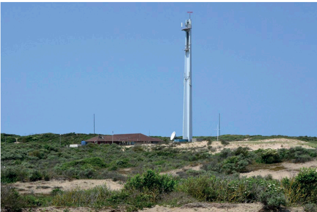
Radio Nora. De duinen bij Noordwijkerhout werden 1928 uitgekozen voor de bouw van een ontvangststation voor radioverbinding met de koloniën. Op deze afgelegen locatie was weinig storing te verwachten vanuit bijvoorbeeld de ontstekingen van auto's, of vanuit de krachtige zendstations zoals Radio Kootwijk op de Veluwe. Het station wordt nog steeds aangeduid als Radio Nora (Noordwijk Radio). In 1939 werden bunkers gebouwd, een noodvliegveld aangelegd en militairen gelegd. De Duitsers gebruikten het station om contact te maken met U-boten en om vijandelijk radioverkeer af te luisteren. Na de oorlog bleef het ontvangststation in gebruik bij Defensie. Inmiddels zijn ook satellietshotels geplaatst. Foto: Huhu Uet, Wikimedia Commons.
